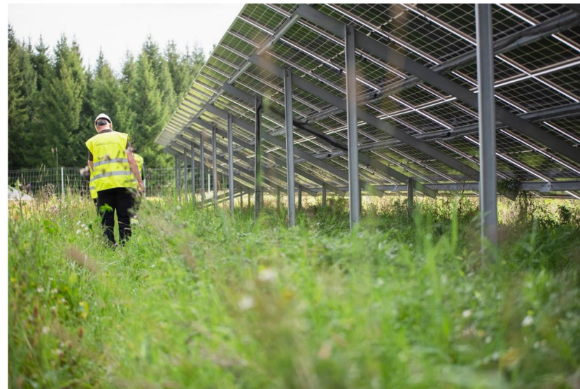
Kuva 33: Esimerkki aurinkovoimapaneeleista, joiden korkeus on n. 3 – 3,5 m. Aurinkopaneelit asennetaan metallirakenteeseen telineeseen, joka mitoitetaan kestäämään lumi- ja tuulikuorma.
