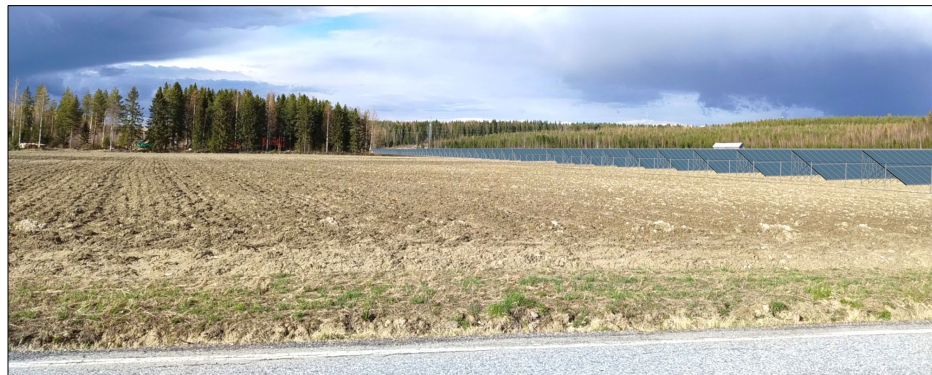
Kuva 33: Esimerkki aurinkovoimapaneeleista, joiden korkeus on n. 3 – 3,5 m. Aurinkopaneelit asennetaan metallirakenteeseen telineeseen, joka mitoitetaan kestäämään lumi- ja tuulikuorma.
