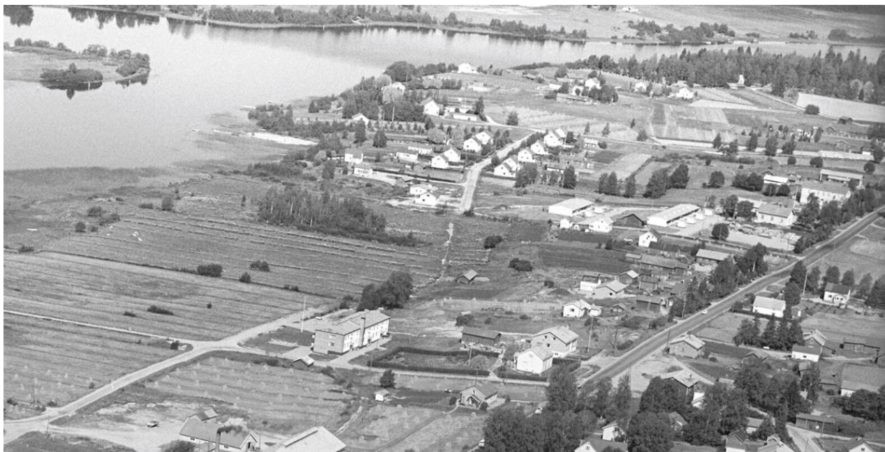
Kuva 3-7. Vuoden 1964 viistoilmakuva laajemmalla alueella kaava-alueen eteläosassa. Nykyiseen Kirkonsalmentien ja Opettajantien risteykseen on noussut yksi pienkerrostalo, muuten alue on pientalovaltaista.
