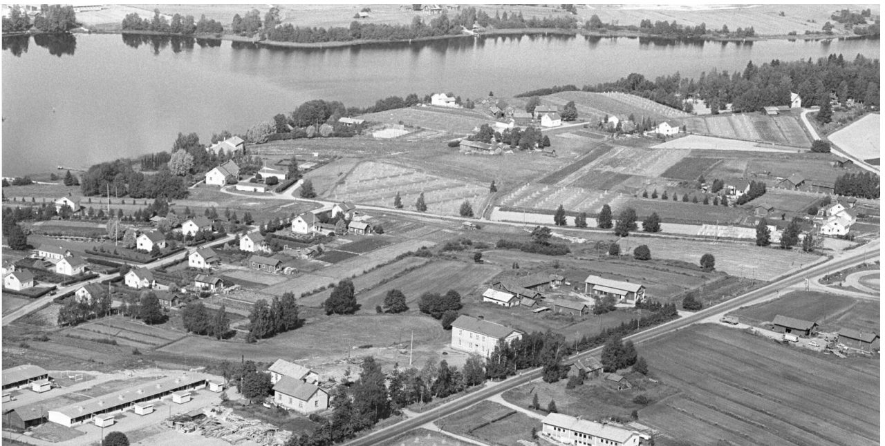
Kuva 3-6. Vuoden 1964 viistoilmakuvassa näkyy Kirkonsalmentien molemmin puolin 1940- ja 1950-luvuilla valmistuneiden omakotitalojen rivistö ja kaava-alueen pohjoisreunalla muutamia yksittäisiä pihapiirejä. Rakennukset Kirkonsalmentien molemmin puolin ovat keskenään samanlaisia ja niiden pihamaat ovat suuria. Päärakennuksen sijoittuvat tien varteen ja piharakennukset ovat suurehkon pihan sivustalla. Pihamaat on kuvan perusteella varattu hyötyviljelyyn.
