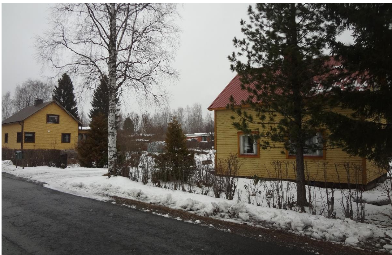
Kuva 5-7. Kirkonsalmentien ja Pappilantien risteyksen lähellä olevia 1940–50-lukujen rakennuksia.
