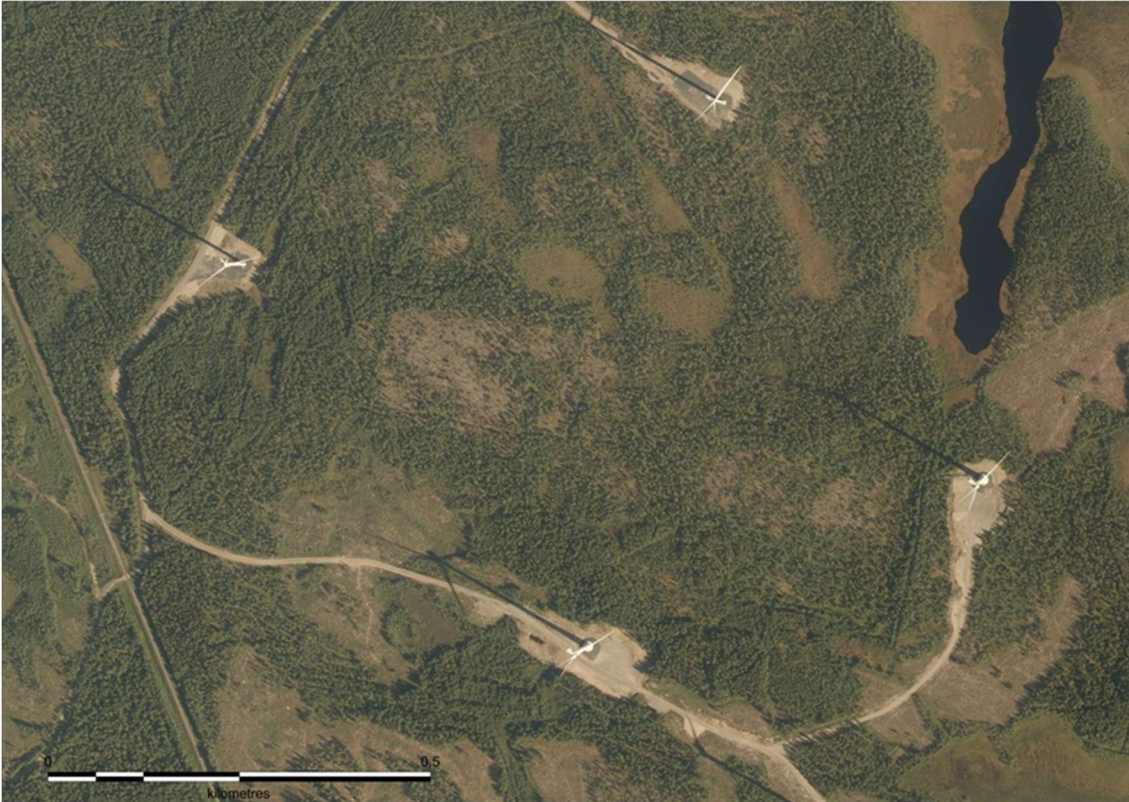
Kuva 80. Ilmakuvasa näkyy toiminnassa olevia tuulivoimaloita. Tuulivoimaloita varten on rakennettu huoltotiet ja nostokentät. Tuulivoimaloiden ympäristössä ja välialueilla aikaisempi maankäyttö on säilynyt ennallaan.
