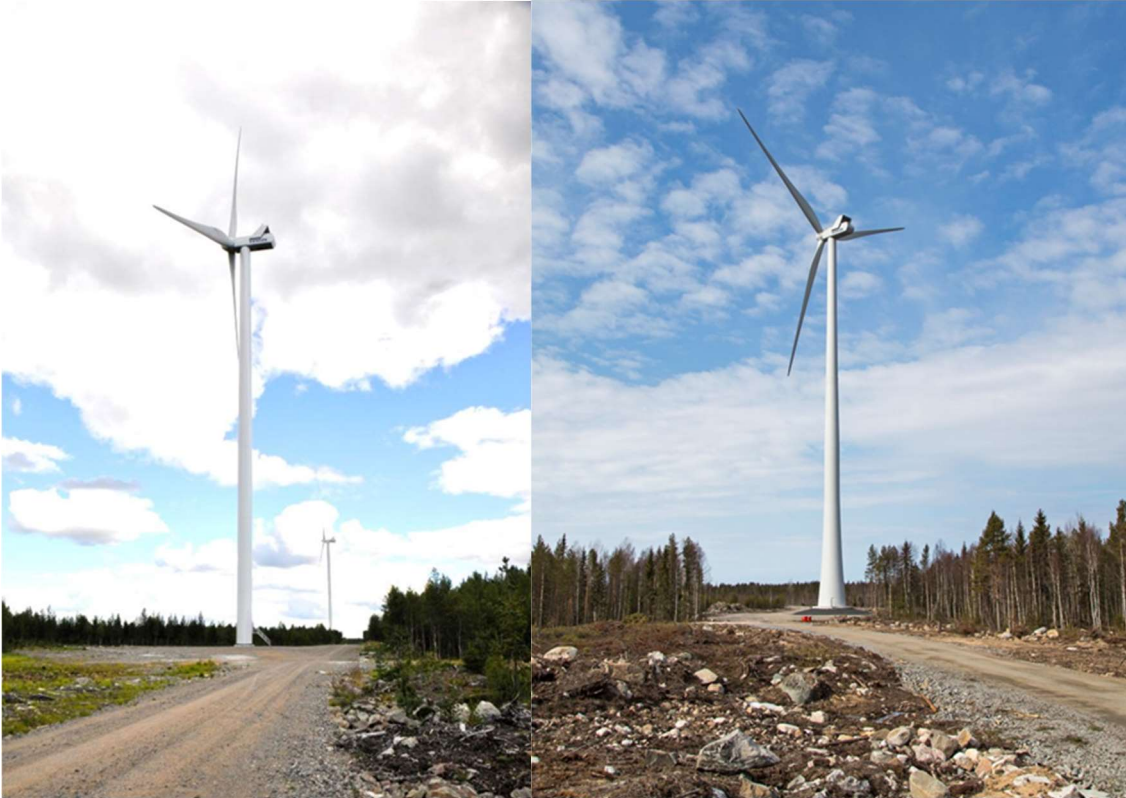
Kuva 81. Vasemmalla on esimerkki teräslieriötornista ja oikealla hybriditornista.
