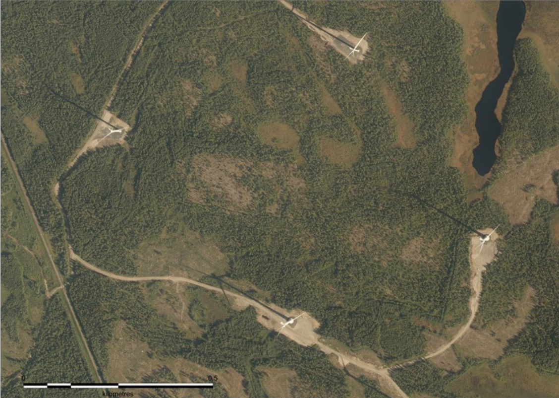
Kuva 80. Ilmakuvassa näkyy toiminnassa olevia tuulivoimaloita. Tuulivoimaloita varten on rakennettu huoltotiet ja nostokentät. Tuulivoimaloiden ympäristössä ja välialueilla aikaisempi maankäyttö on säilynyt ennallaan.
