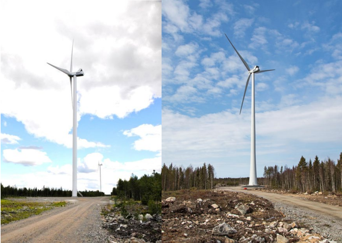
Kuva 81. Vasemmalla on esimerkki teräslieriötornista ja oikealla hybriditornista.
