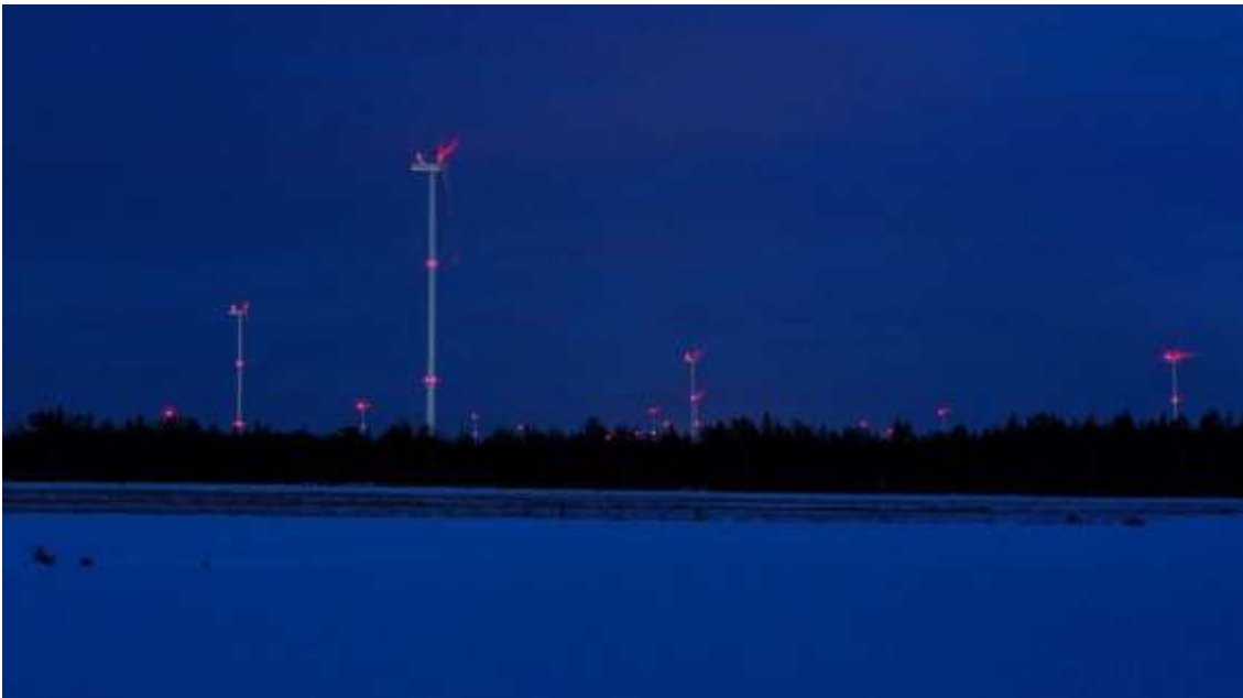
Kuva 82. Kiinteät punaiset lentoestevalot.
