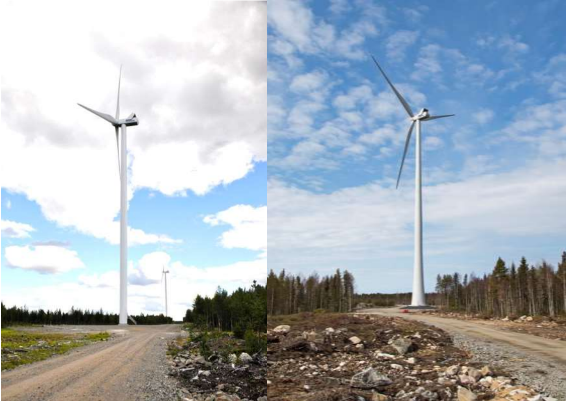
Kuva 80. Vasemmalla on esimerkki teräslieriötornista ja oikealla hybriditornista.
