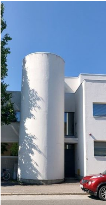
Kuva 8a Rapattua julkisivua.
