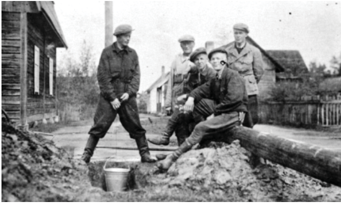
Kihmulaa sähköistetään 1920-luvulla.
