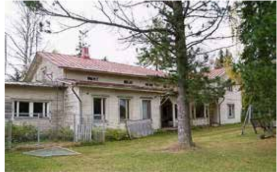
Päärakennuksen jatkeeksi on rakennettu lämpökeskus ja muita tiloja. Myös ikkunat on uusittu. Kuva 2010-luvulta.
