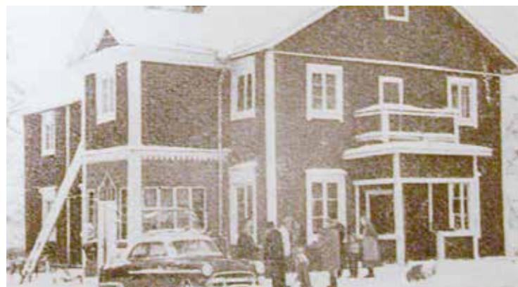
Marjoniemen päärakennus ennen vuoden 1963 remonttia (vasemmalla) ja kesällä 2010. Kuisti on muutettu saunaksi, ja itäpäädyssä on lämpöhuone. Itäpäädyssä ollut parveke on poistettu. Lähde: Suomen maatilat -julkaisu.
