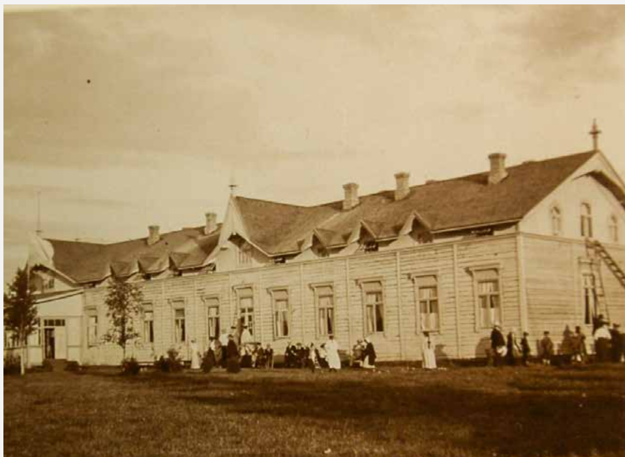
Runnin kylpylähotelli elokuussa 1910. Rakennus on hirsipinnalla, päätykolmiot laudoitettu. Rakennukseen on lisätty hotellihuoneita ikkunoineen ullakkokerrokseen, kuten myös vasemmalla osittain näkyvä, lapekatteinen ruokasalin laajennus- ja kuistiosa. Kuva: Herman Renfors, Kuopion kulttuurihistoriallinen museo.
