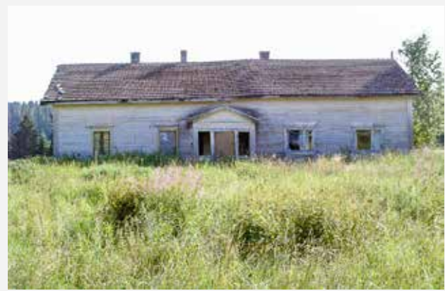
Roninmäen tilan rakennukset eivät edusta sotilastorppavaihetta. Torpasta on muodostui elinvoimainen 1900-luvun alkupuolen maalaistalo. Vanhan päärakennuksen tupaosan kehikko saattaa olla sotilastorpan ajoilta.
