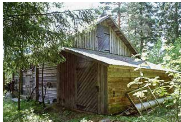
Hieman pihapiirin ulkopuolella sijaitsevassa riibessä näkyy muutoksia eri ajoilta. Etualalla oleva matalampi osa lienee entinen ruumen.
