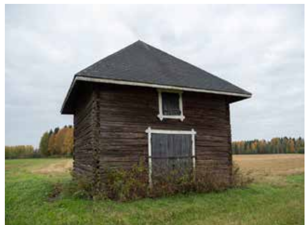
Ahmonsaaren viljamakasiini eli aitta on todennäköisesti peräisin 1700-luvulta. Rakennus on lajissaan ainutlaatuinen Ylä-Savossa.
