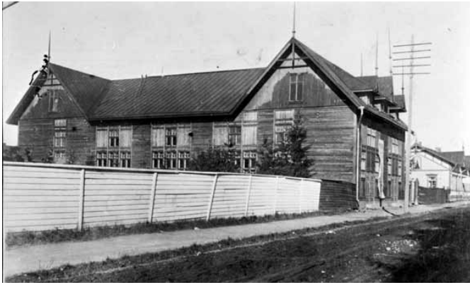
Kuva 1900-luvun alkuvuosikymmeniltä, Pohjolankatua ei ole kivetty ja Naistenyhdistyksen talo on rakentamatta.
