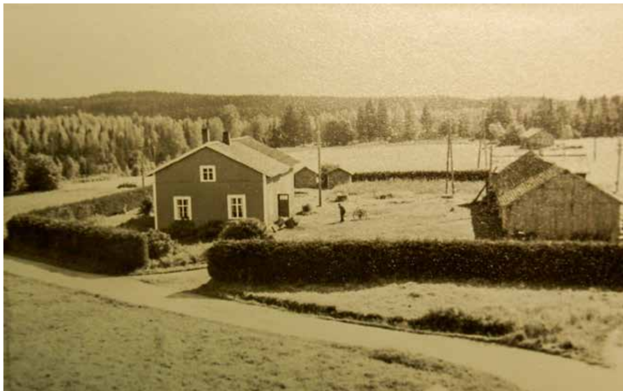
Väättäälän pihapiiri muodostuu päärakennuksesta, taloussrakennuksesta sekä pikkuaitoista. Kuva on otettu 1956.
