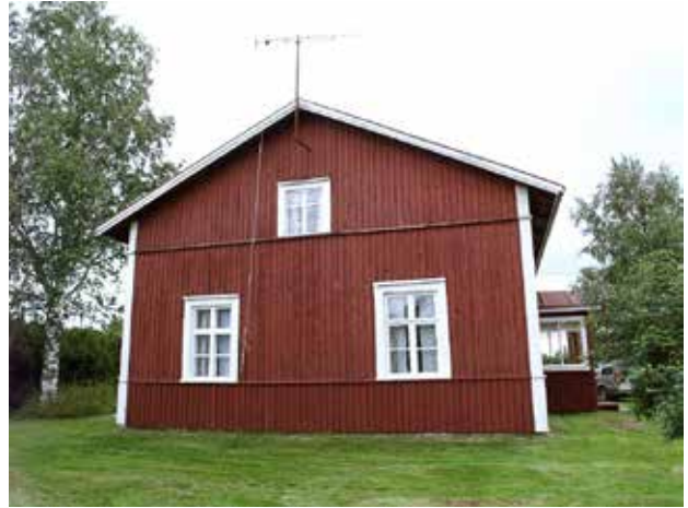
Kamaripäädyn rimalautavuorauksen helmaa on korjattu perinteisesti katkaisemalla laudoituksen alaosa ja laudoittamalla se uudelleen.
