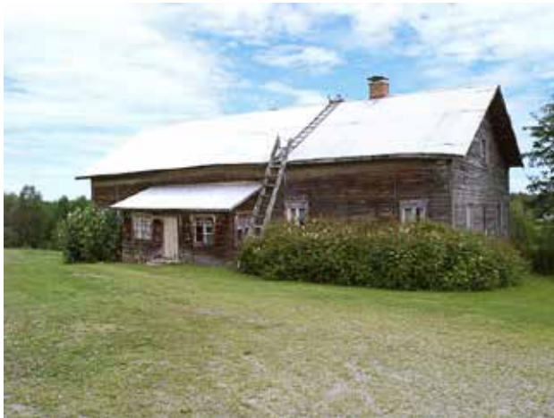
Pitkäkösken tilan vanha päärakennus. Vanhin osa on vuodelta 1802.
