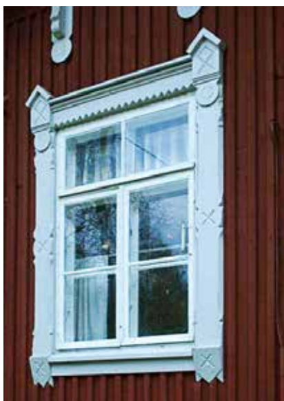
Taipaleen vahtituvan ikkunat.
