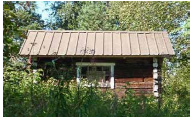
Paja sijaitsee hieman pihapiirin ulkopuolella. Pajan katto uusittiin 2012.
