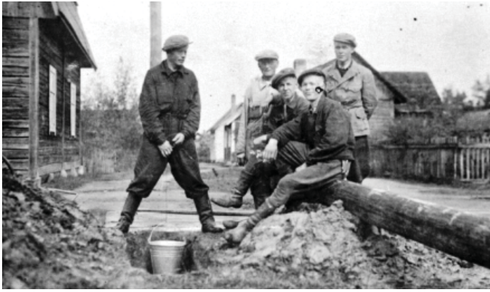
Kihmulaa sähköistetään 1920-luvulla.
