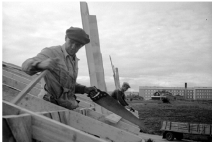
1960-luvun alkua, sairaalan takana rakennetaan.
