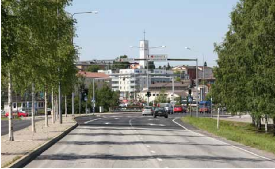
Eteläinen Pohjolankatu. Kohti Iisalmen keskustaa Paloisvirran yli.
