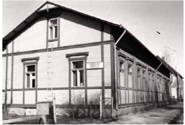
Katolta puuttuvat kaksi frontonia, jotka on rakennettu uudelleen peruskorjauksen yhteydessä. Lisäksi poikkipäättyyn on lisätty sivuikkunat.
