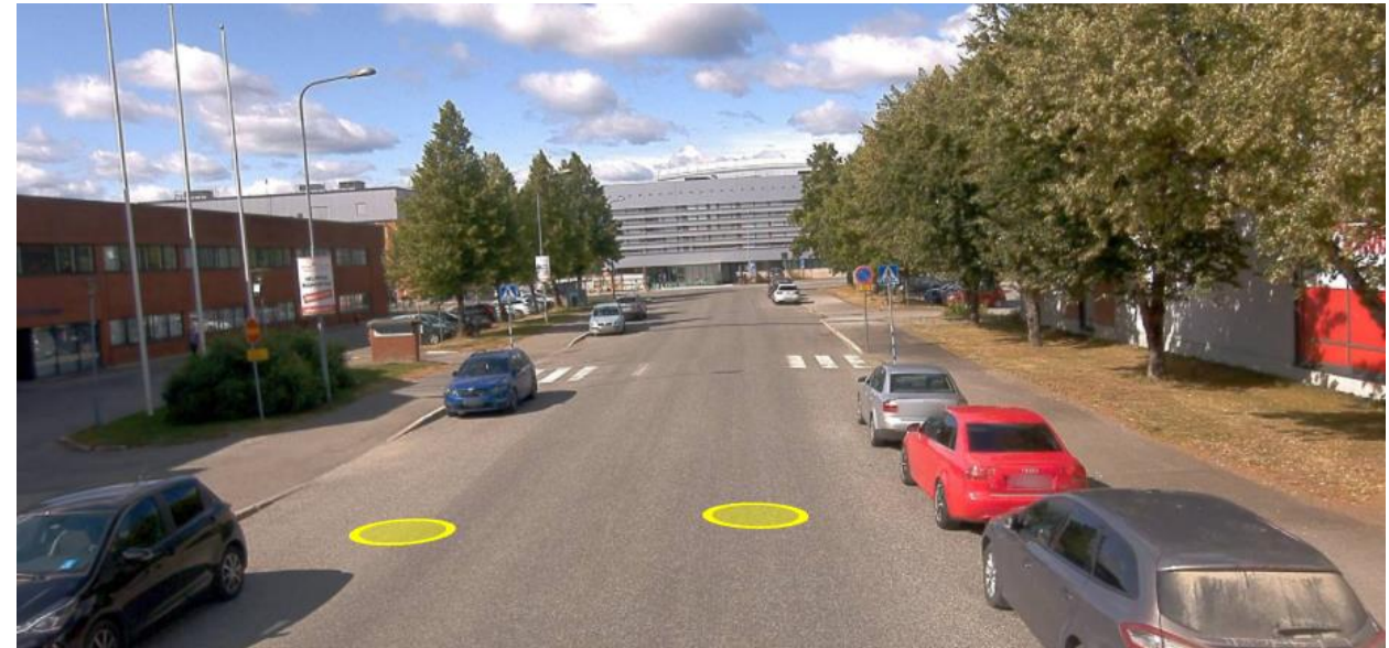
Kuva 25. Pitkä suojatie Meijerikadulla, terveysaseman pääoven läheisyydessä, lähde Mapspace Viewer
