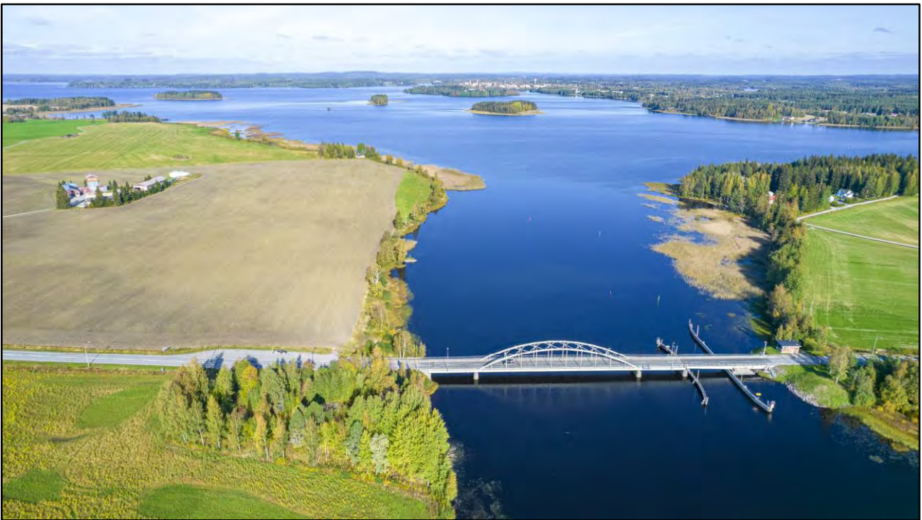
Kuva 1. Maisemaa Itikkasalmen sillalta pohjoiseen Porovedelle, taustalla Iisalmen keskustaa. Kuvauskopterin kuva. (AKDG6958:3)
