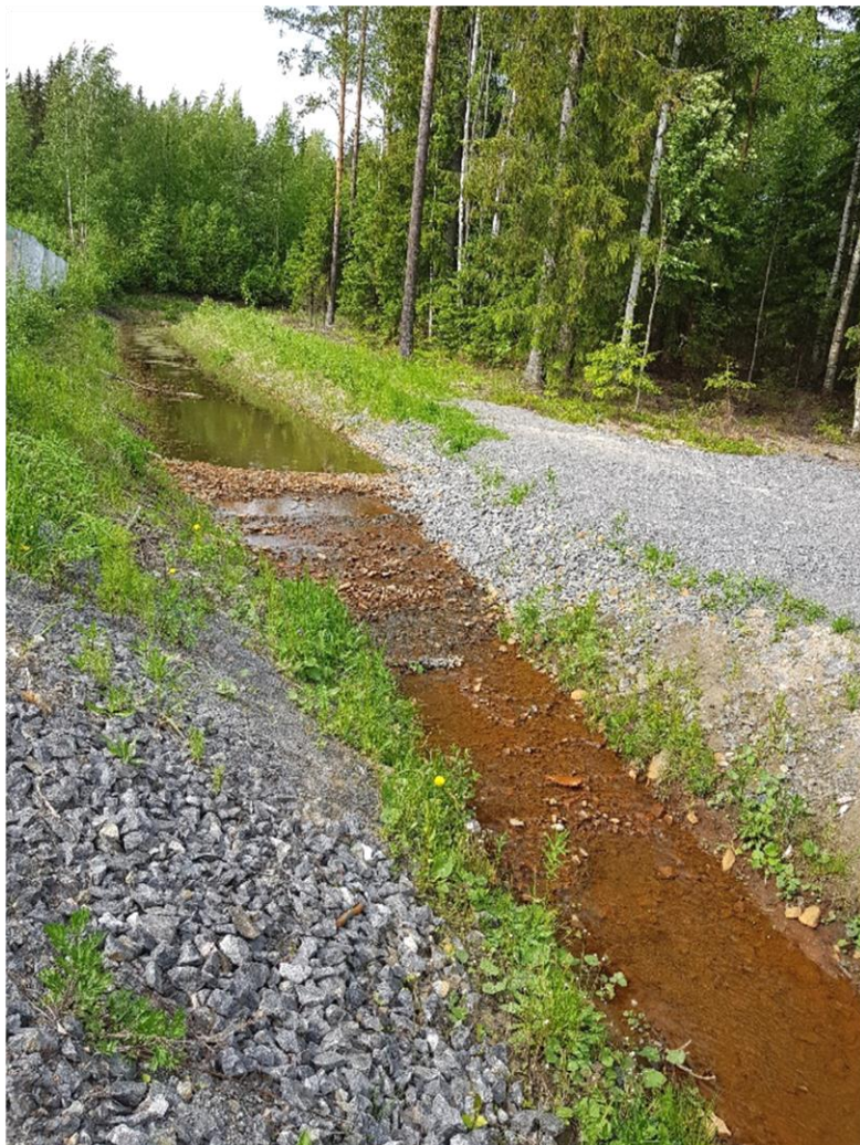
Kuva 15. Yksinkertainen suotopato karkeasta kiviaineksesta. Kyseisen kohteen uomassa on patojen sarja.
