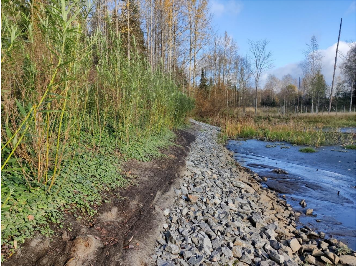
Kuva 16. Kasvipeitteinen ja monikerroksisen suotopato hulevesien käsittelyssä.
