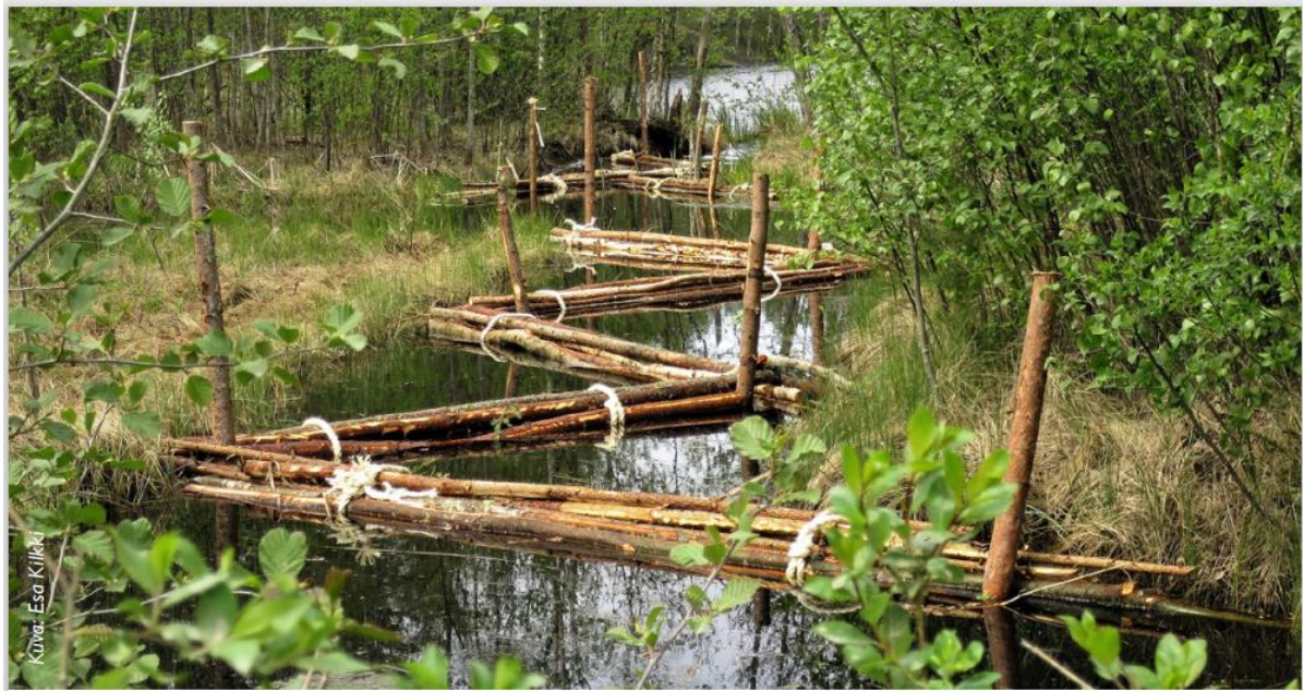
Kuva 14 PuuMavesihankkeessa toteutetut puiset pohjakynnykset. Kuva Esa Kiltti (PuuMavesihankkeen loppuraportti, Vuorio K-M ym. 2021)
