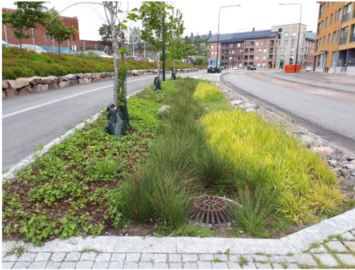
Kuva 22. Vasemmalla toteutunut biosuodatusalue kadun varrella Helsingin Kuninkaantammassa. Oikealla periaatekuva katurakenteeseen sijoitutusta biosuodatuksesta.
