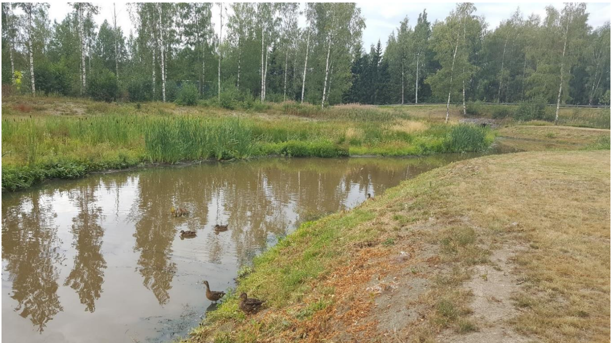
Kuva 18: Luonnonmukainen uoman levennyksenä toteutettu laskeutusallas, jota ympäröivä tulvaniitty ta- soittaa virtaamia ja parantaa altaan toimintaa tulvatilanteissa.
