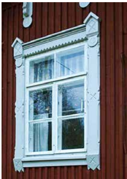
Taipaleen vahtituvan ikkunat.
