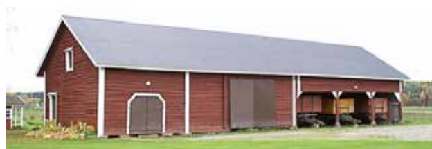
Aitta ja kalustusuoja.
