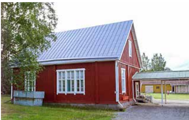
Runnin vanhassa koulurakennuksessa on kaunis saumapeltikatto perinteisine jalkaränneineen. Alkuperäinen kate oli todennäköisesti päre. Ullakon ikkuna on alkuperäinen, mutta ensimmäisessä kerroksessa ikkunat on uusittu. Tyyppi on kuitenkin vanhan kaltainen ulos-sisään-aukeava puuikkuna.
