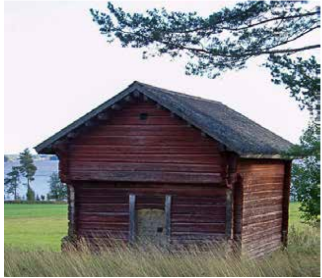
Niiralanniemen aitta on yksi vanhimpia säilyneitä rakennuksia Iisalmen seudulla.
