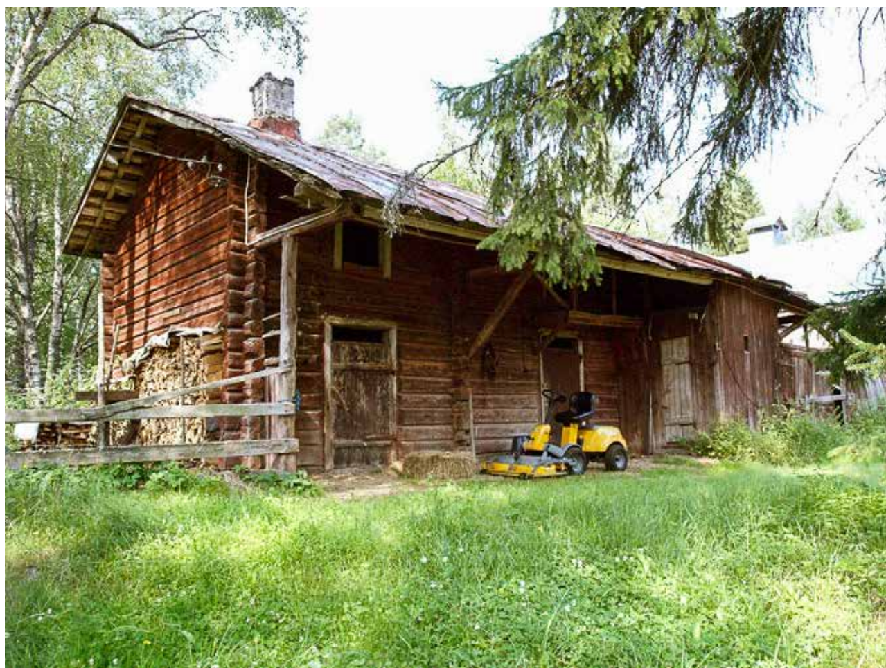
Tallirakennus, jossa oli kanala ja talli kolmelle hevoselle. Oikealla on huussi, jonka takana on lantala.
