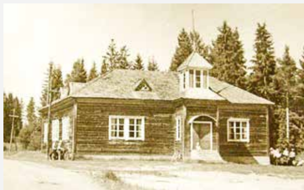
Vuonna 1930 valmistunut mäkitupa. Rakennus on myöhemmin vuorattu. Pärekatto on vaihdettu peltikatteeseen. Kattoikkunat on todennäköisesti poistettu samassa yhteydessä. Pohjoispäädyn katon aumaus on jossain vaiheessa suoritettu. Myös ovi on uusittu. Tielle asti hyvin näkyvä nimikyltti on lisätty talon pääjulkisivuun.
