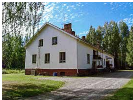
Poroveden koulun julkisivu on säilynyt hyvin alkuperäisessä asussaan. Ikkunapuitejakona on 1940-luvulla suosittu tapa jakaa ikkuna alaosaan vaakapienoilla tai karmilla. Vasemmanpuoleinen kuva on ajoittamaton, oikeanpuoleinen 2010-luvulta.
