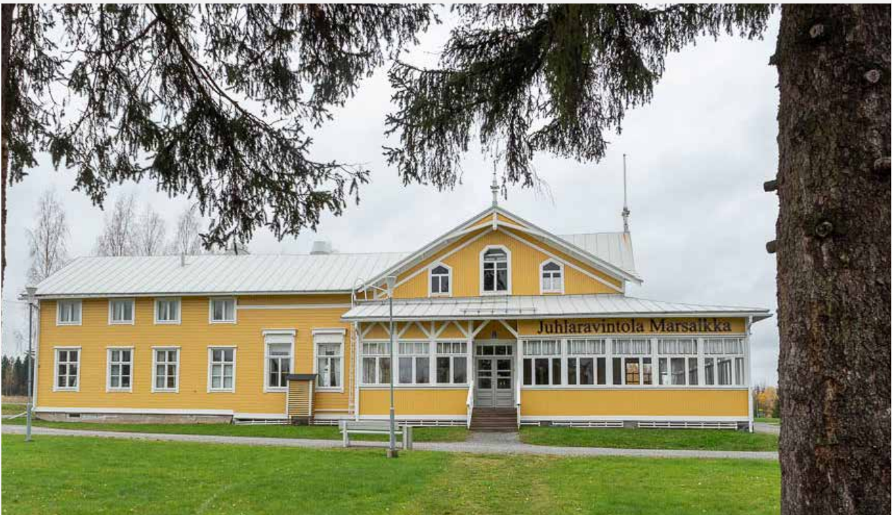
Runnin vanha kylpylä kunnostettuna 2019.
