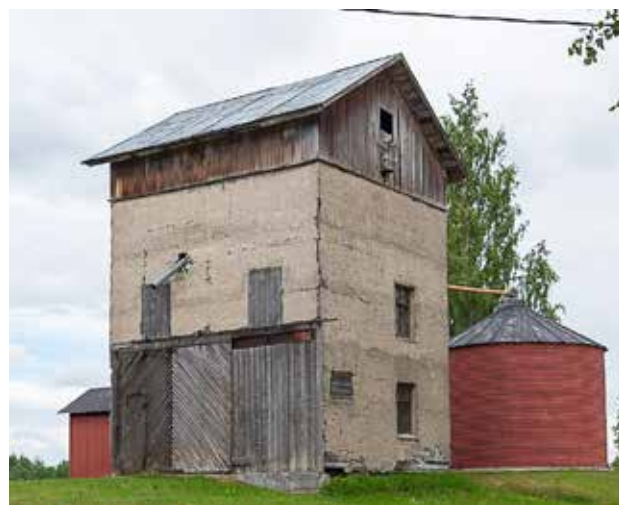
Vesitorni edusti 1930-luvulla uusinta karjatalousteknologiaa: se oli osa karjan ja hevosten automaattista juottokuppijärjestelmää.
