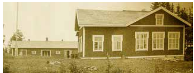
Haapajärven vanha kansakoulu oli ensimmäisiä maalaiskansakouluja Iisalmessa. Se rakennettiin 1896 ja purettiin 1960-luvulla.
