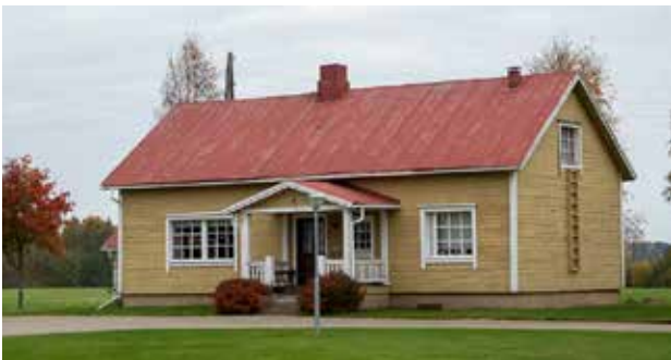
Ahmonsaaren pihapiirin toinen asuinrakennus on alkuaan toiminut väentupana tai pihanpäänä. Rakennus on siirretty navetan luota nykyiselle paikalleen 1940-luvulla.
