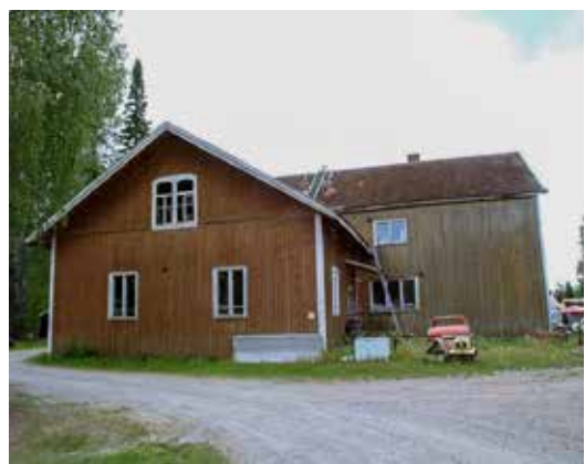
Pörsänmäen koulua laajennettiin sotien jälkeisenä pula-aikana 1940-luvulla. Vanhassa osassa on nykypäiviin säilynyt alkuperäinen yläkerran ikkuna.
