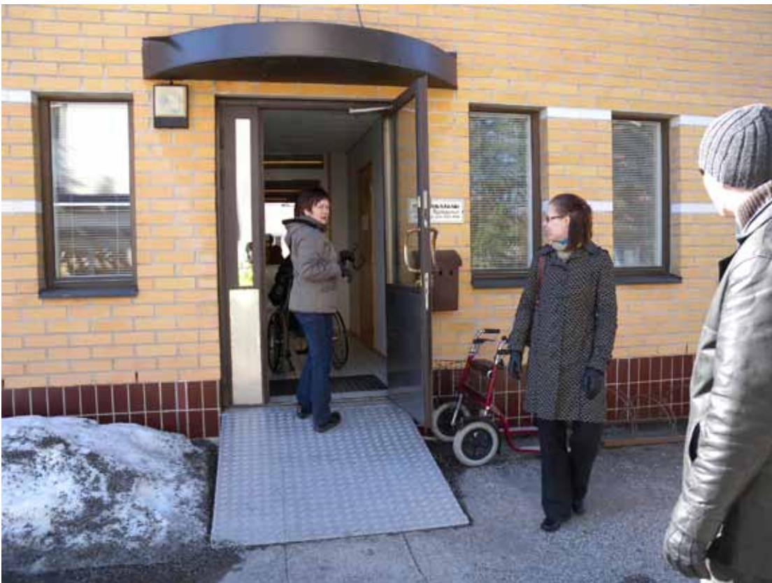
Kuva 7. Hammaslääkärin sisäänkäynti oli hyvin toteutettu; riittävän loiva ja leveä luiska sekä itsestään auki pysyvä ovi.
