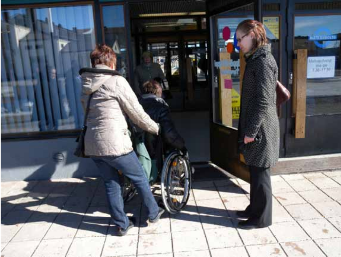
Kuva 6. Linja-autoaseman sisäänkäynti ei ole esteetön.
