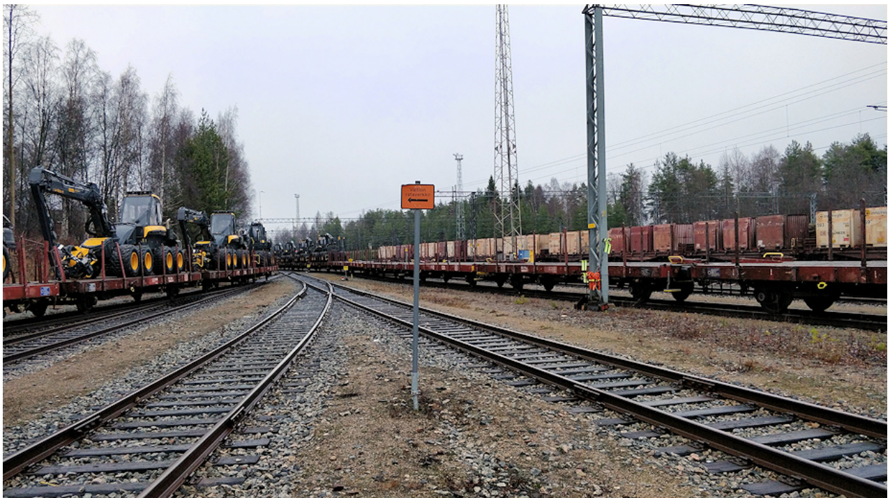
Kuva 20. "Pätkät"-raiteisto raiteiden R022 ja R023 välistä pohjoiseen (marraskuu 2018).
