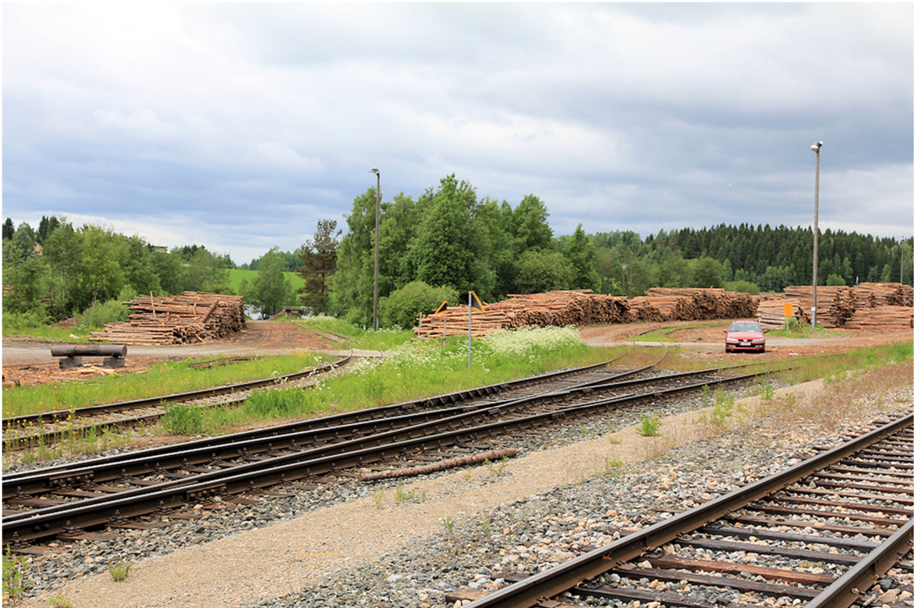
Kuva 22. Soinlahden raiteita R296, R294 ja R293, etualalla R292 (kesäkuu 2017).
