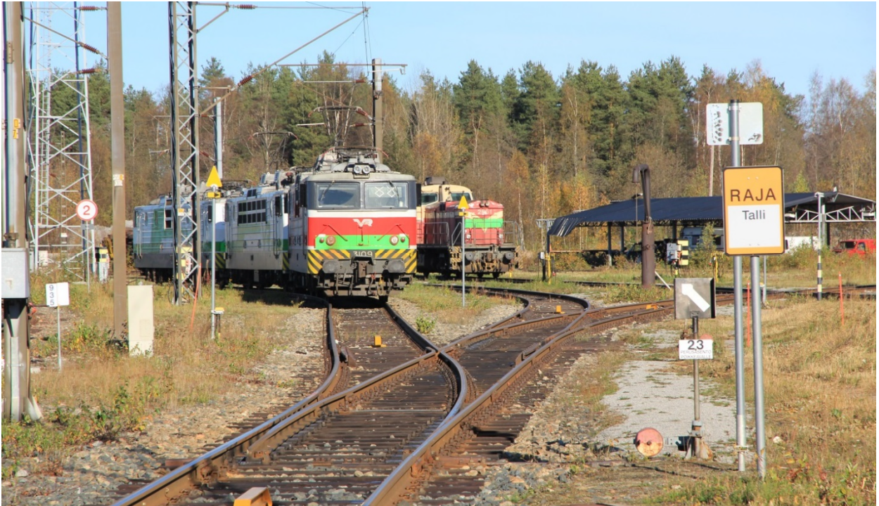
Kuva 15. Talli-raiteisto vaihteelta V023 raiteille R012 ja R013. R012 sähköistetty (lokakuu 2015).
