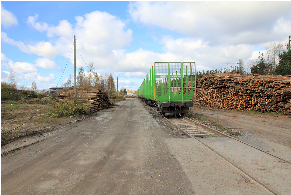
Kuva 11. Iisalmen teollisuusraiteiden raide R002 pohjoiseen (kesäkuu 2014).
