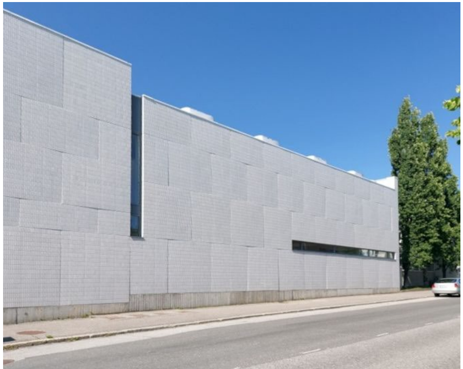
Kuva 8b Klinkkerilaatoitettua julkisivua. (Riistakatu)
