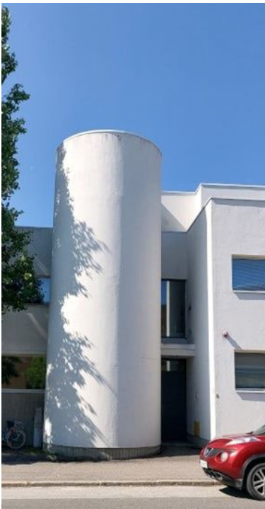
Kuva 8a Rapattua julkisivua.
