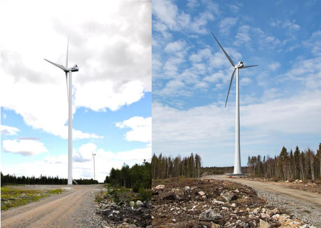
Kuva 87. Vasemmalla on esimerkki teräslieriötornista ja oikealla hybriditornista.
