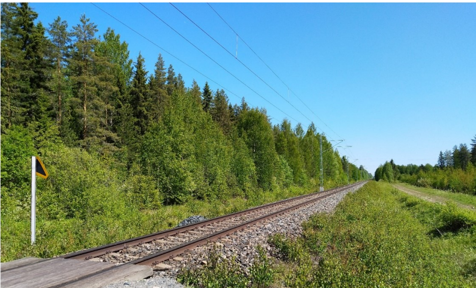
Kuva 28. Sähkönsiirtoreitit ylittävät rautatien Kiurujoki-Luupujoki välisellä alueella.
